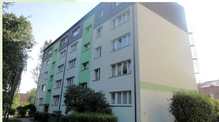
Termomodernizacja budynku os. Norwida 6 Wykonanie: 2017.07.15 Koszt: 488 325 zł
