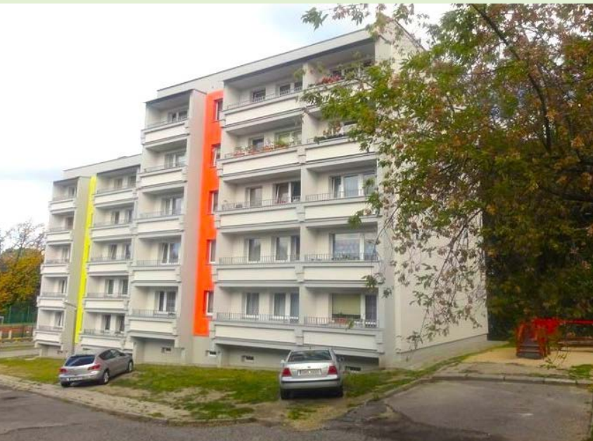
Przebudowa i termomodernizacja budynków – Stara Droga 2c i 2d Wykonanie: 2019.05.30 Koszt: 881 734,84 zł
