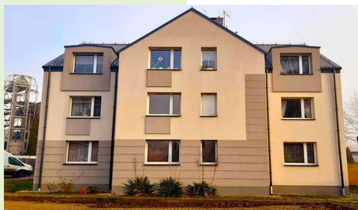
Termomodernizacja budynku ul. Wyzwolenia 31 Wykonanie: 2017.12.19 Koszt: 162 697,00 zł
